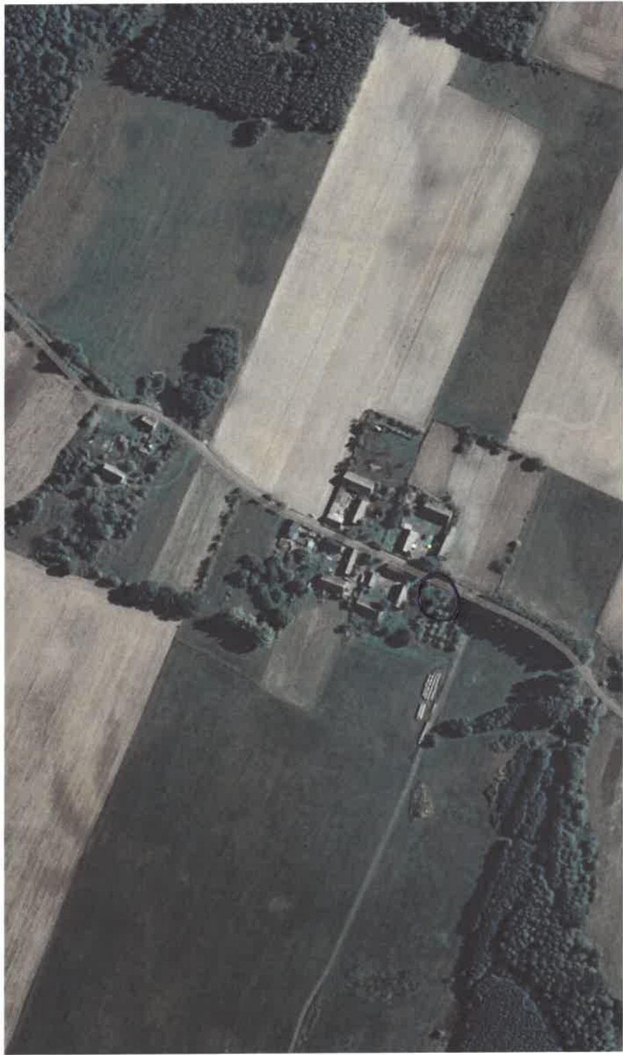
Załącznik nr 1 do interpelacji Andrzeja Puławskiego z dnia 29.01.2025 r. w sprawie uszkodzonej sieci wodociągowej w miejscowości Piątkowo.
